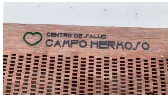
Instalación De Letrero De Fachada Centro De Salud Campo Hermoso
