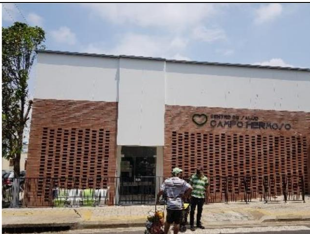
Fachada Centro De Salud Campo Hermoso
