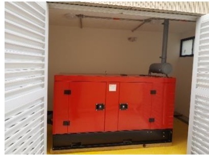
Planta eléctrica Centro de salud la libertad
