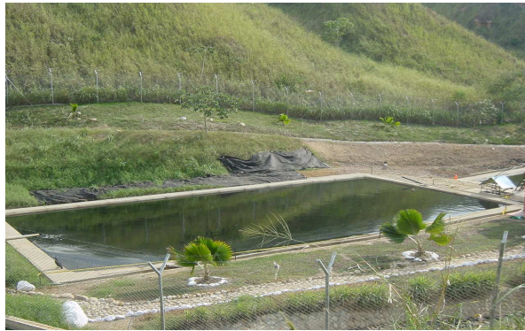
Fotografía 2. 7 Planta para el tratamiento de lixiviados generados en el Carrasco
