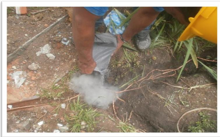
*suministro de instalación: de cable cobre línea desnuda N°2 para malla tierra con 3 varillas coper well de 2.4m para protección de gabinete y transferencia*
