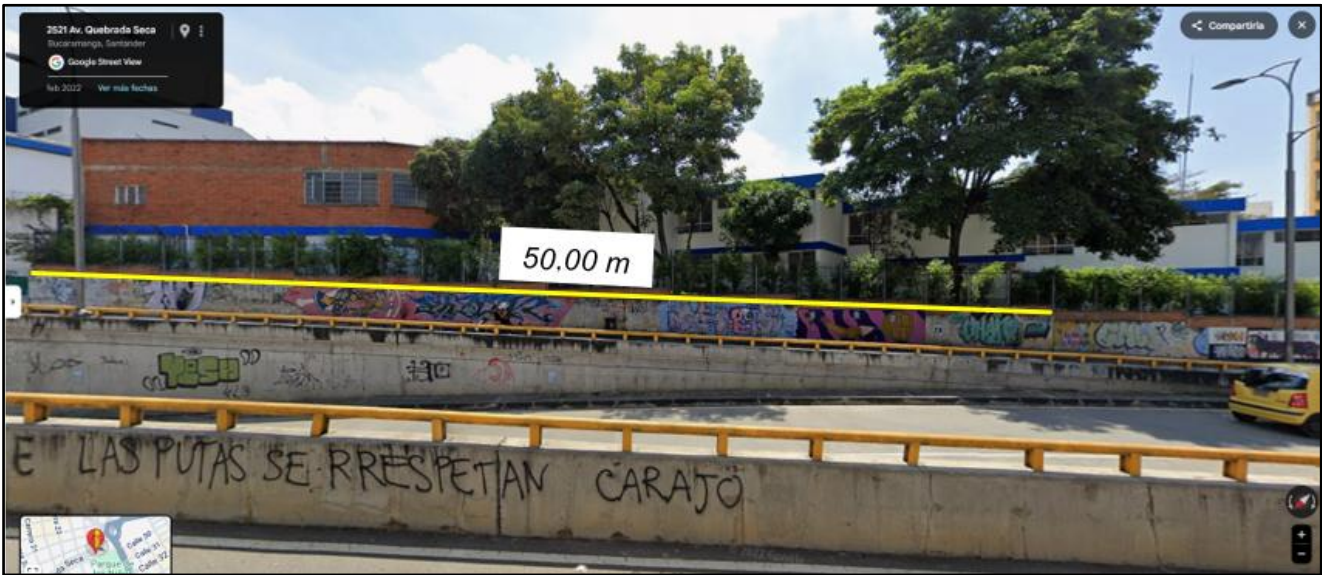
Fotografía 10: Muro perimetral, subiendo la Av. Quebradaseca con carrera 26. Link de GoogleMaps/ https://maps.app.goo.gl/aDQnGiKdKRLr5mJd7
