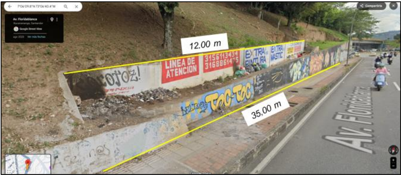
Fotografía 06-07: Muro de contención horizontal Puerta del Sol, Sentido Norte-Sur/ Autopista Bucaramanga- Floridablanca, Link GoogleMaps/ https://maps.app.goo.gl/rpjRkhumDGkU7qAW7
