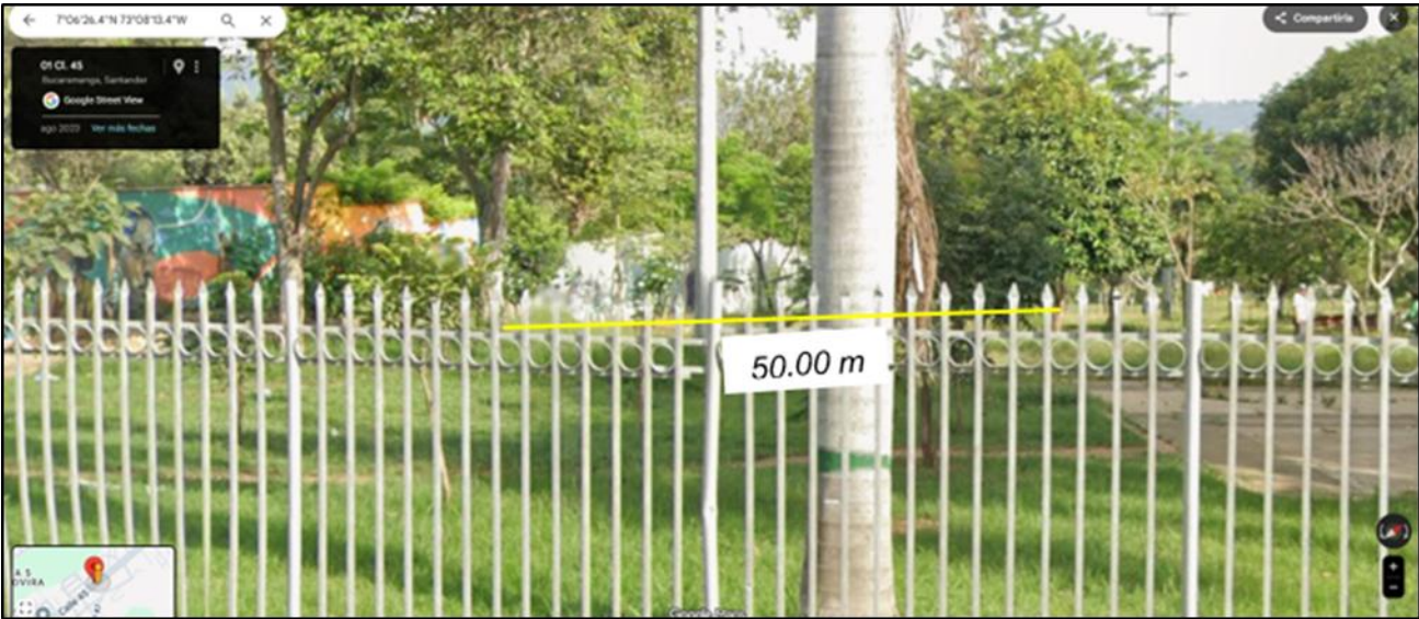
Fotografía 11: Muro perimetral dentro del parque de la vida que colinda con la parte posterior del recrear campo hermoso, Link de GoogleMaps/ https://maps.app.goo.gl/BoHWkKGmwi9FWswD9
